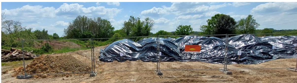
Figure 12 : Photographie de l'aire de stockage (26/05/2023)
