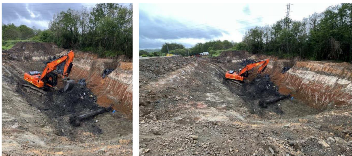
Figure 17 : Photographies de l'excavation des terres suspectées polluées avec zone noirâtre (17/05/2023)
