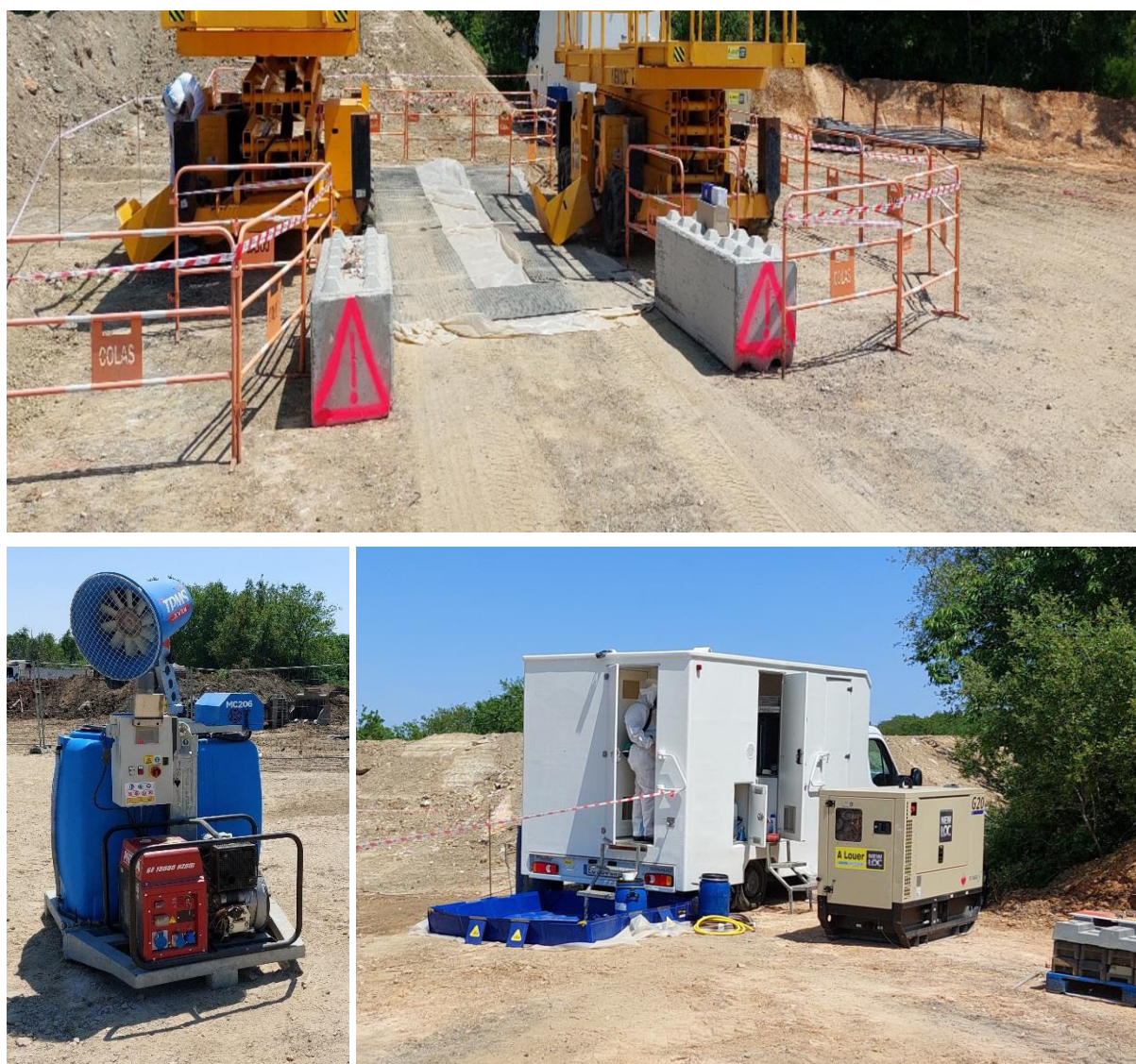
Figure 23 : Photographies du matériel utilisé lors du conditionnement des terres à évacuer (01/06/2023)
