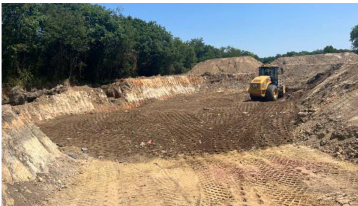
Figure 24 : Photographie du remblaiement de la fouille (02/06/2023)
