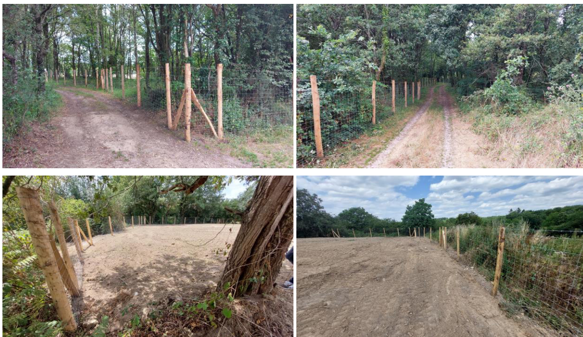
Figure 32 : Photographies des clôtures mises en place
