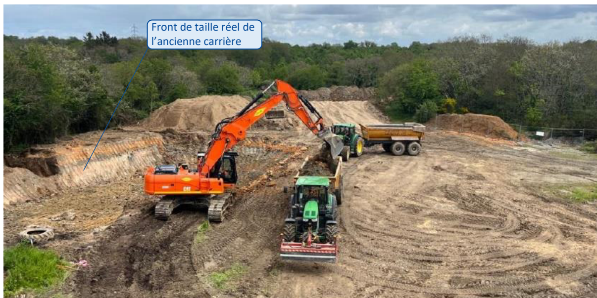
Figure 14 : Photographie de l'excavation des terres surmontant les terres suspectées polluées (10/05/2023)
