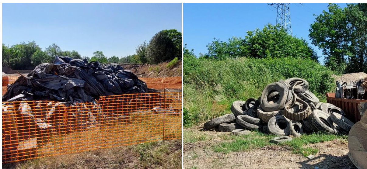
Figure 15 : Photographies d'une partie des déchets triés et évacués (02/06/2023)
