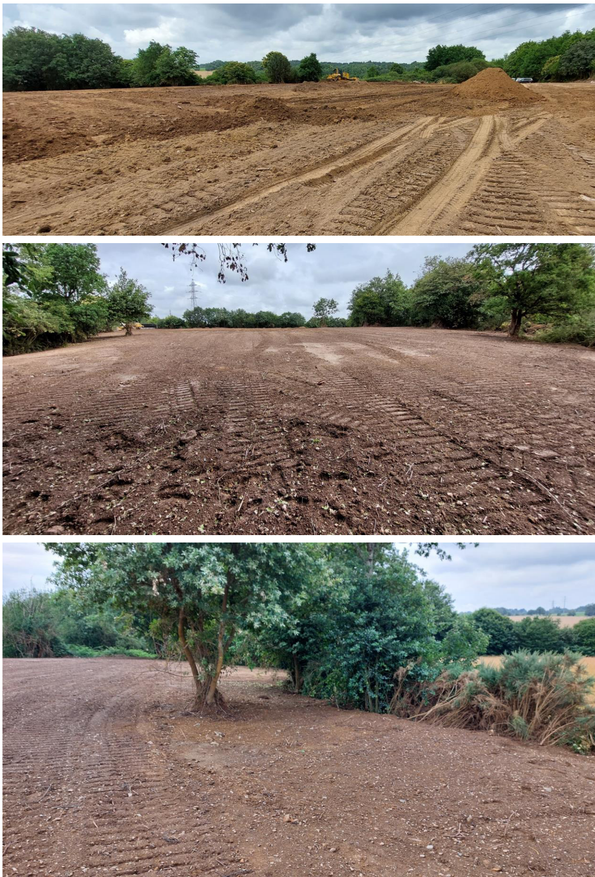
Figure 30 : Photographies des travaux de reprofilage
