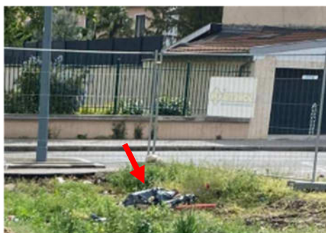
Figure 8 : Les tuyaux potentiellement amiante confinés sous les bâches
