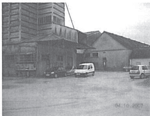
Vue sur le silo métallique (droite) et le silo à orge (arrière plan)
