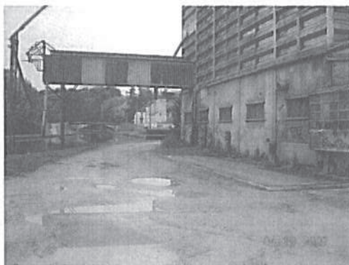
Vue sur l'arrière de silo métallique avec le pont bascule
