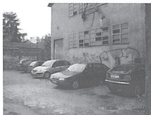
Vue de l'entrée du nouveau silo
