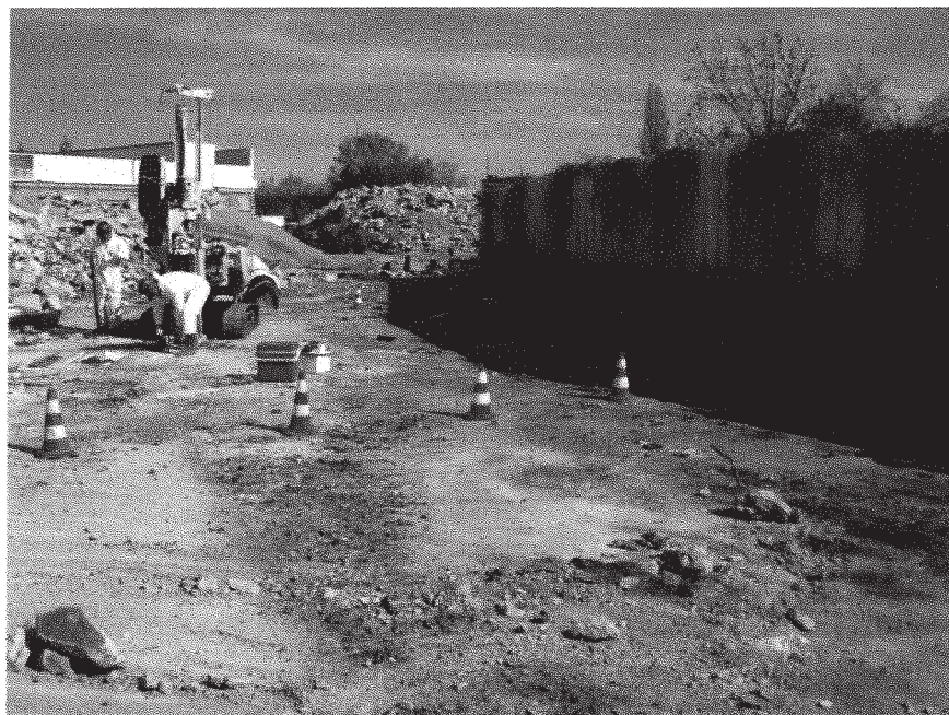
Zone du forage SB 128-1
