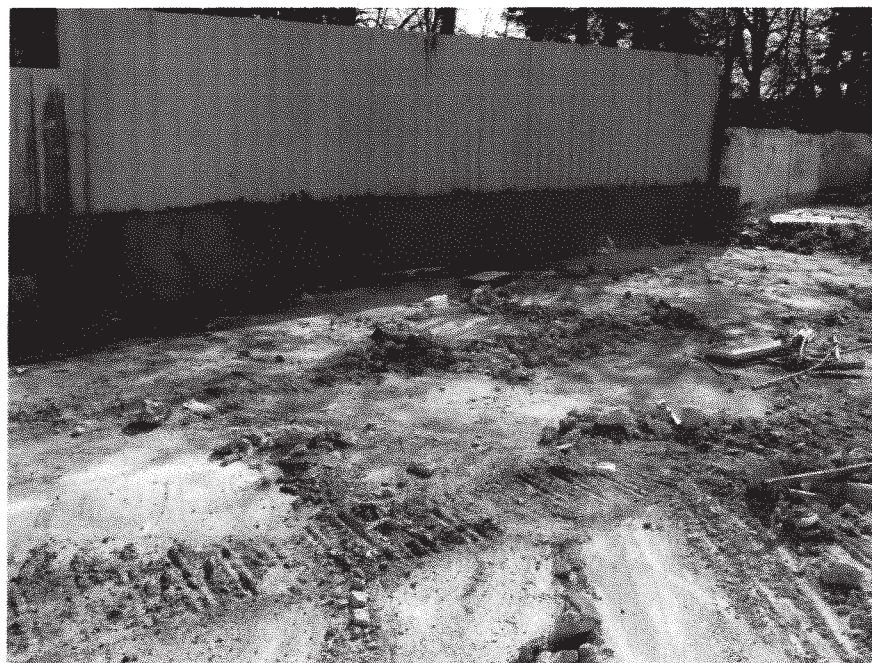
Zone du forage SB 128-2
