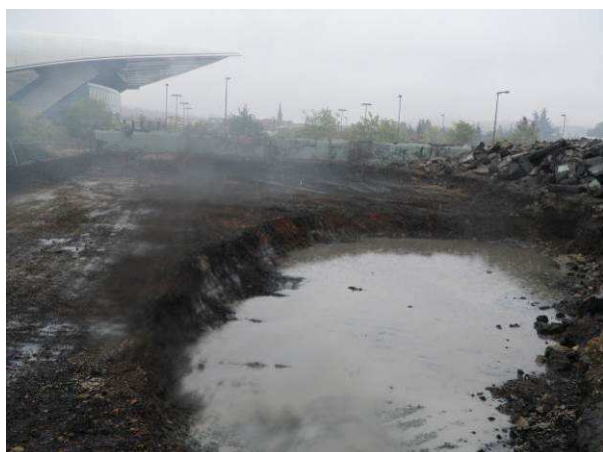
Vue de l'ouest de la zone du secteur 5. Eaux de pluie retenues dans la fouille du P19 à 2 m de profondeur
