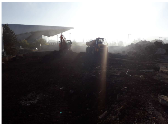
Secteur 5 : Terrassement en cours
