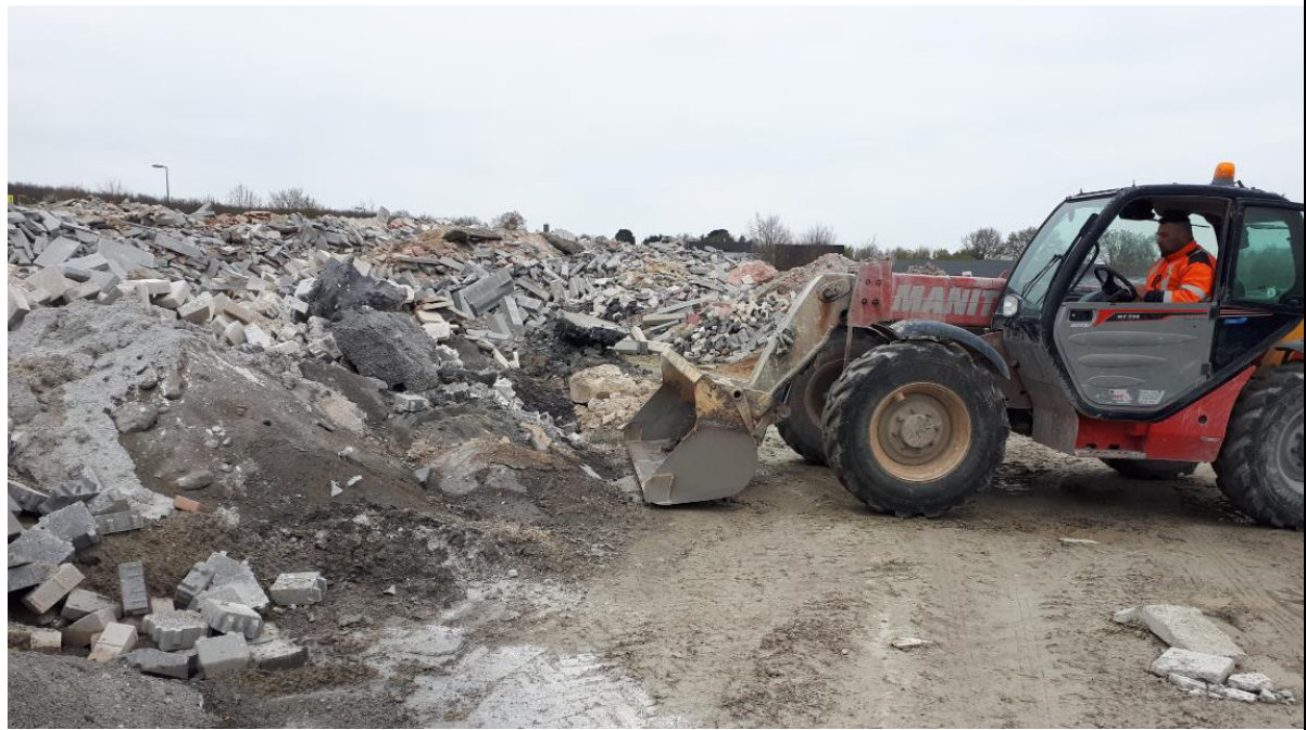
Matériaux provenant des rebus inertes de fabrication de produits en béton (provenant du Lion d'Angers) utilisés pour le remblaiement des fouilles
