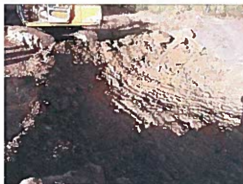
Fouille excavée vers l'ouest
