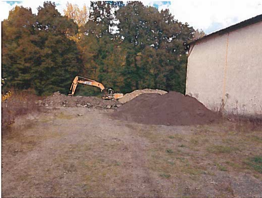
Matériaux sains : remblai et terre végétale (premiers apports en début de chantier-octobre 2016).
