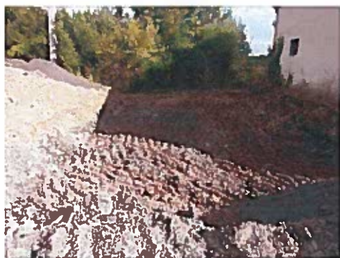
Vue de la fouille « ancien atelier de dépollution »
