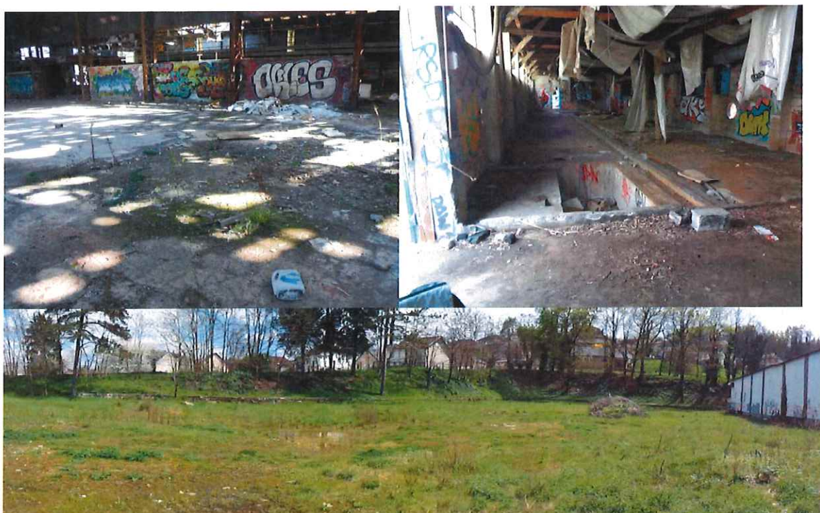
Figure 5 : photos des zones à excaver
