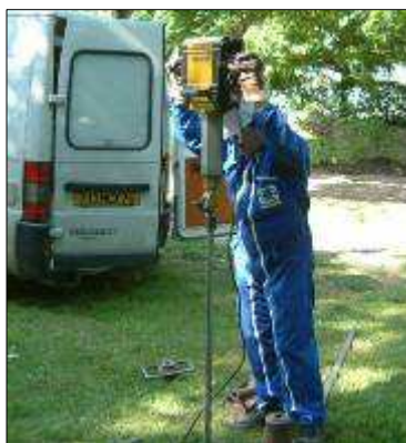
FIGURE 2 : MATERIEL LEGER « SOL » UTILISE LORS DES SONDAGES
