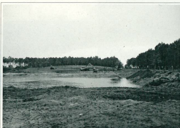
Vue du chantier du nord au sud : lagune et dôme en second plan
