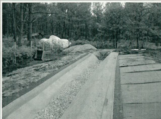
Vue sur fossé de drainage périphérique en cours de réalisation – côté sud du dôme
