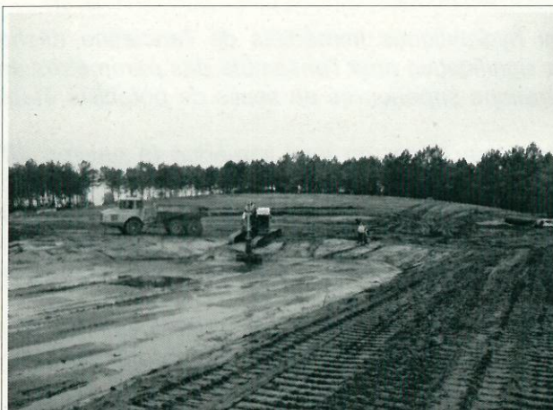
Vue sur dôme et travaux de finition de purge des déchets.
