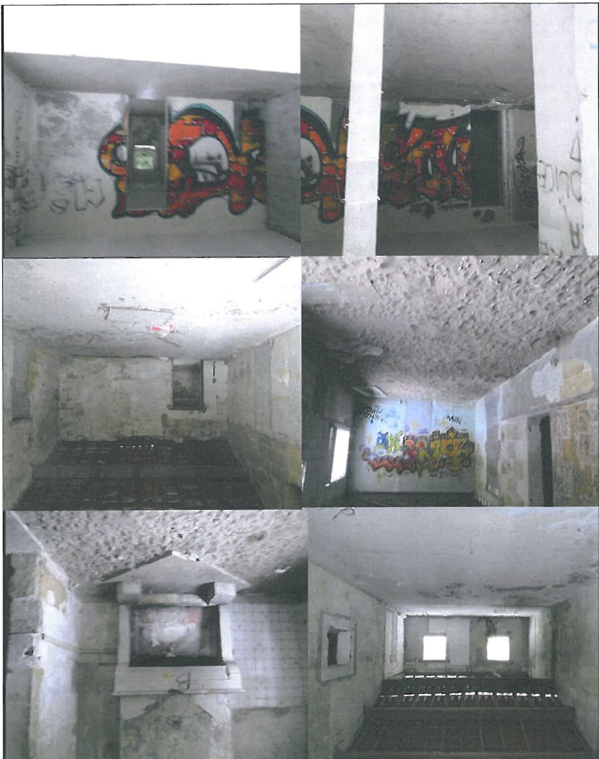
Figure n°13 : Bâtiment annexe (Intérieurs du Sud au Nord) - Téréo, novembre 2014. (14.150.RA.001.01.F.013)
