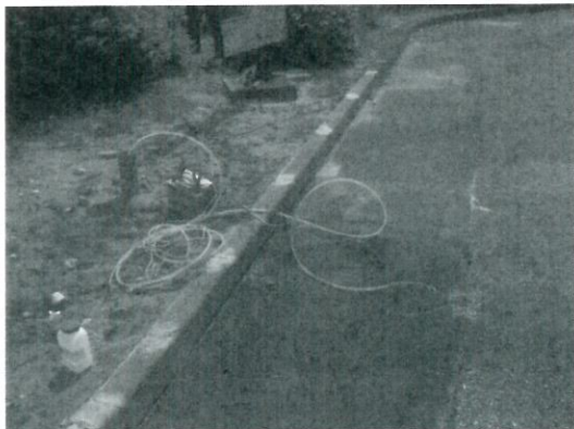
Piézomètre Amont (Pz1)
