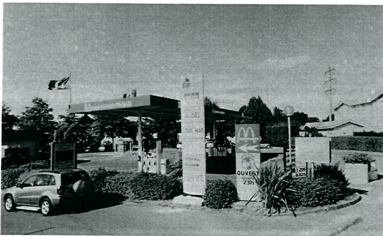
Figure 1 : Vue générale du site avant démolition
