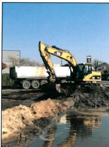
Merlon et fin des terrassements
