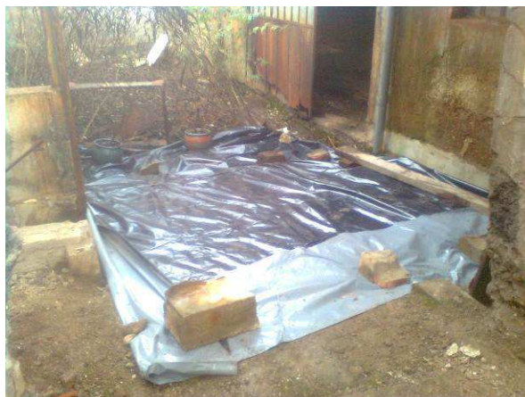
PHOTOGRAPHIE 2 : ETANCHEITE DU TROU N°3 SITUE DANS L'ARRIERE COURS
