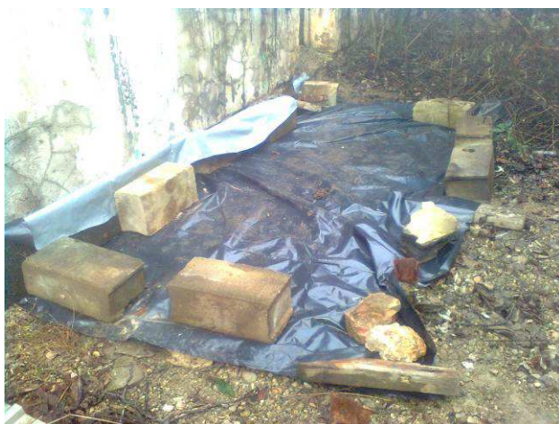
PHOTOGRAPHIE 3 : ETANCHEITE DU TROU N°2 SITUE DANS LE LOCAL DE STOCKAGE
