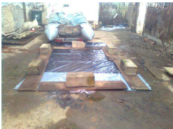
PHOTOGRAPHIE 1 : ETANCHEITE DU TROU N°1 SITUE DANS L'ATELIER DE CHROMAGE
