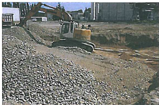
Remblaiement à l'aide de matériaux D'apport
