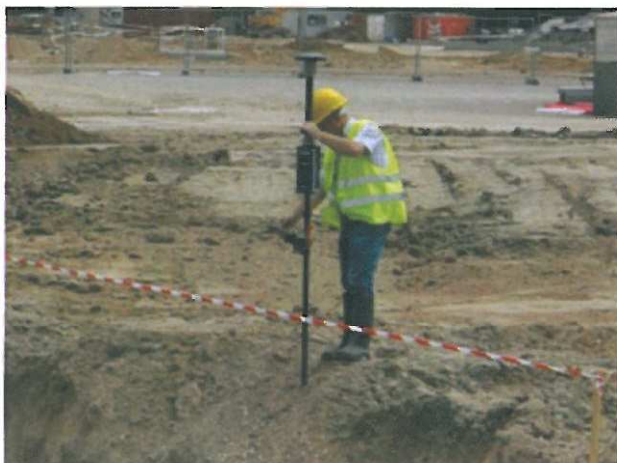
23/06/08 : Levé de la fouille par un géomètre-expert pour validation
