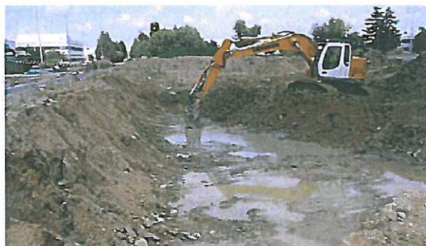
Terrassement des terres polluées
