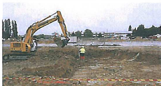
Décapage des terres saines de surface
