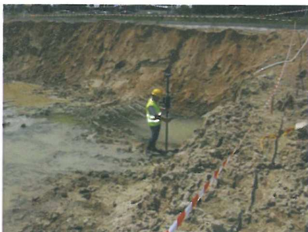
23/06/08 : Levé de la fouille par un géomètre-expert pour validation
