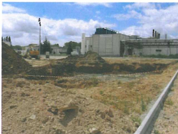
20/06/08 : Vue générale de la zone excavée en fin de terrassement
