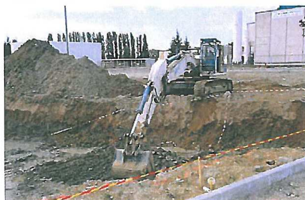
Terrassement des terres polluées
