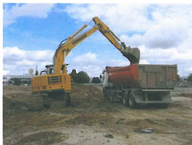
17/06/08 : Excavation et chargement des terres de surface décapées
