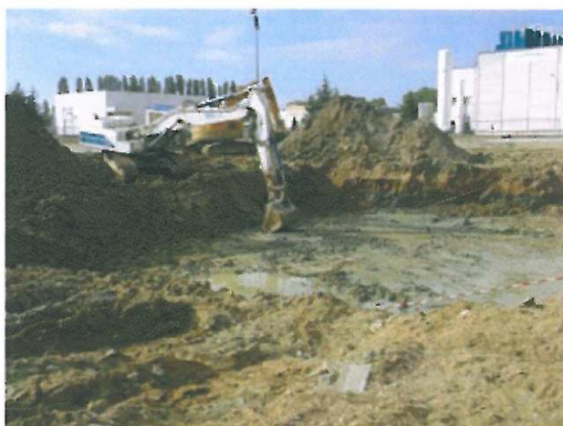
20/06/08 : Poursuite de l'excavation avec une pelle à long bras
