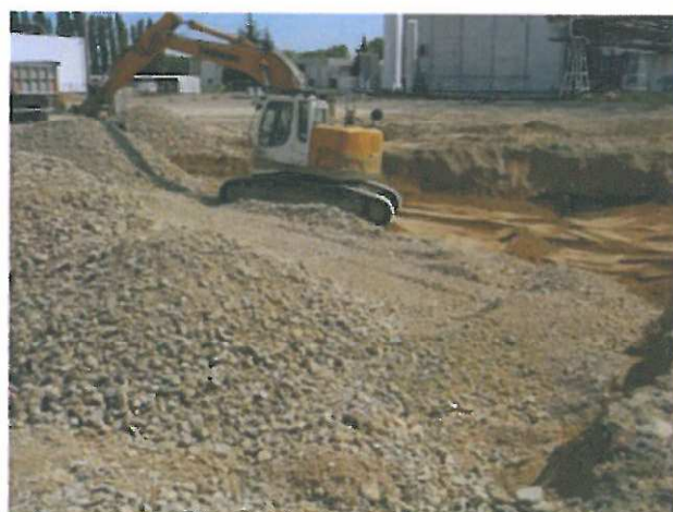
26/05/08 : Poursuite du comblement de la fouille
