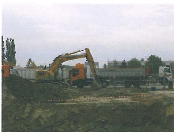
23/06/08 : Poursuite du chargement des terres contaminées à destination du biocentre
