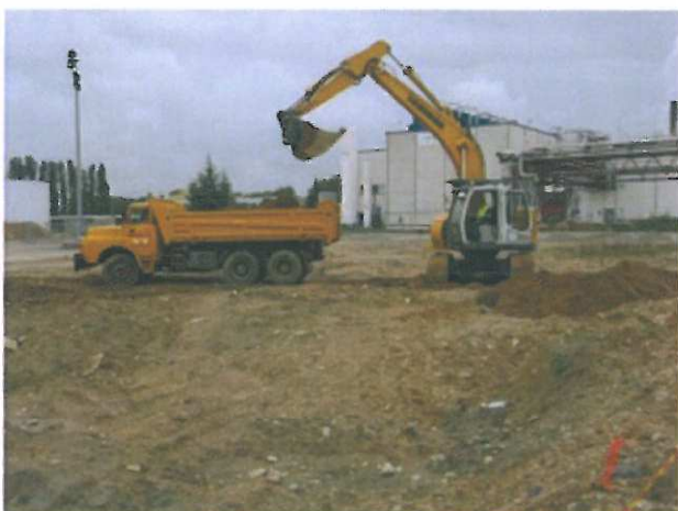
16/06/08 : Décapage des terres de surface et contrôle de la cote de décapage à l’aide d’un niveau laser
