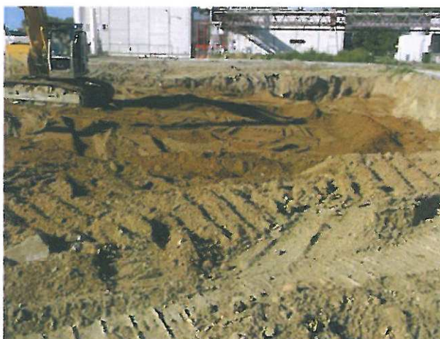
26/05/08 : Finalisation du remblaiement avec les terres décapées et d'apport provenant de Kodak
