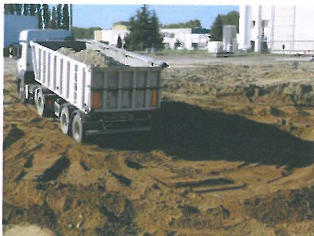
26/05/08 : Réception des matériaux d’apport extérieur (granulats de carrière) pour poursuivre le comblement
