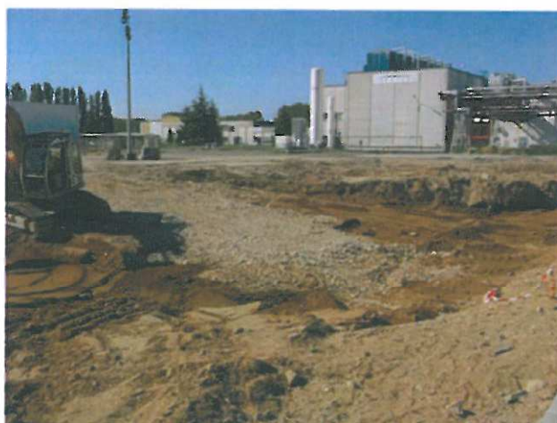
26/05/08 : Poursuite du comblement de la fouille
