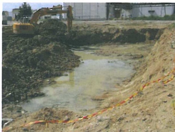
18/06/08 : Excavation des terres contaminées
