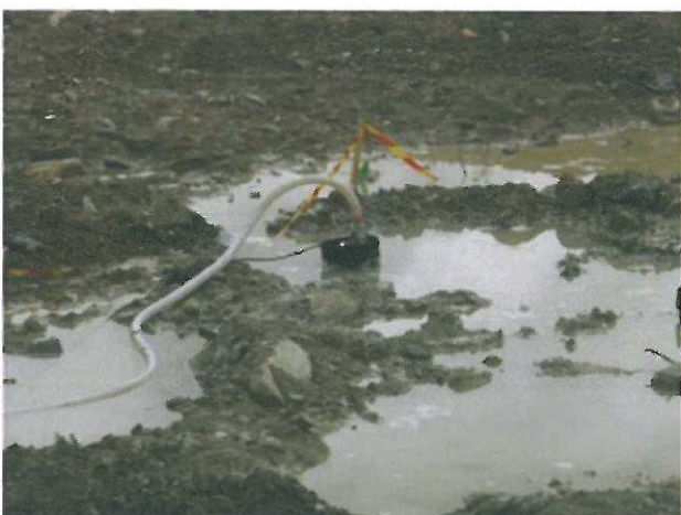
17/06/08 : Pompage des eaux pluviales accumulées dans l’excavation et décanteur équipé de charbon actif avant rejet dans le réseau « eaux usées » du site
