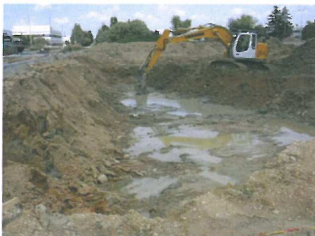
18/06/08 : Excavation des terres contaminées
