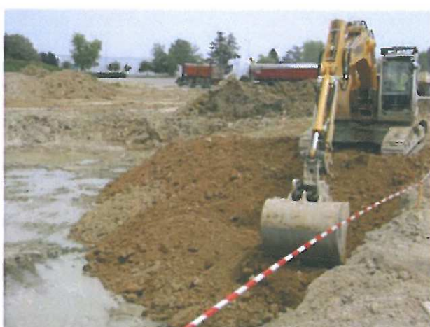
24/05/08 : Remblaiement avec les terres décapées et d'apport provenant de Kodak
