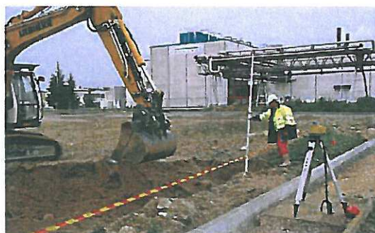
Balisage de la zone d'excavation
