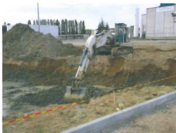
20/06/08 : Poursuite de l'excavation avec une pelle à long bras
