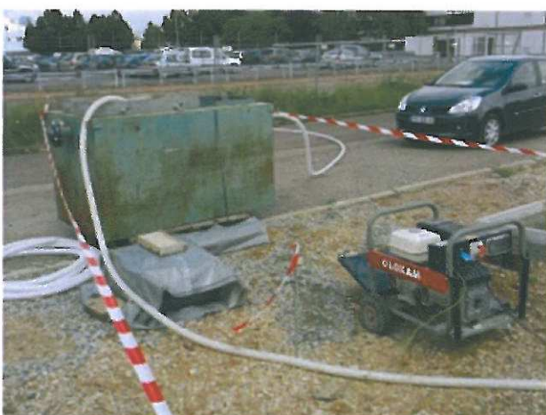
17/06/08 : Pompage des eaux pluviales accumulées dans l’excavation et décanteur équipé de charbon actif avant rejet dans le réseau « eaux usées » du site
