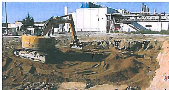
Remblaiement avec les matériaux sains (Décapage de surface)
