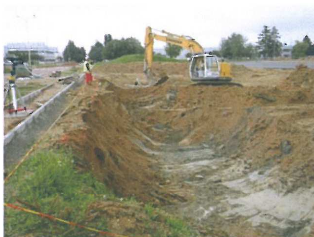
17/06/08 : Excavation et chargement des terres de surface décapées
