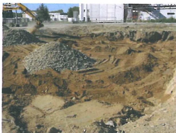
26/05/08 : Réception des matériaux d’apport extérieur (granulats de carrière) pour poursuivre le comblement
