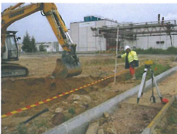
16/06/08 : Décapage des terres de surface et contrôle de la cote de décapage à l’aide d’un niveau laser
