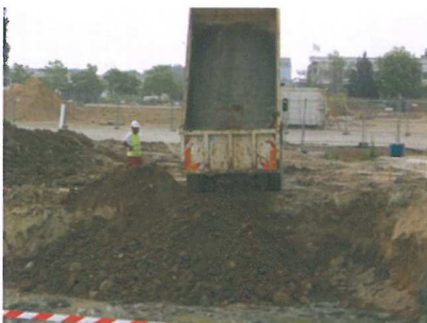
24/05/08 : Remblaiement avec les terres décapées et d'apport provenant de Kodak
