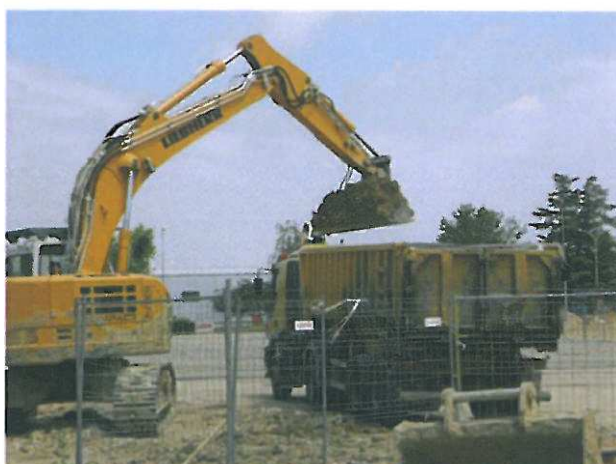
23/06/08 : Poursuite du chargement des terres contaminées à destination du biocentre
