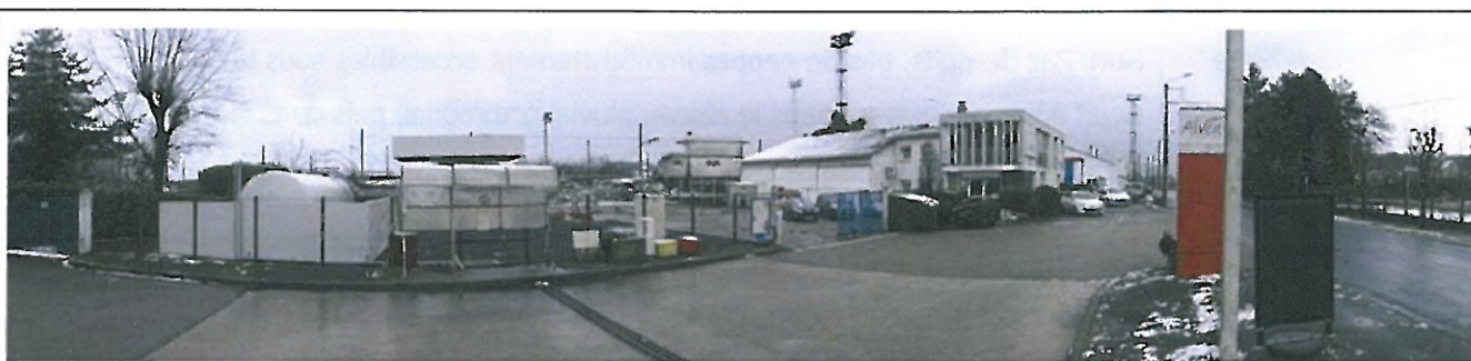
Fig 1. Localisation du site et environnement : milieu industriel en bordure de la voie ferrée et de la gare de triage de Brive-la-Gaillarde. Derrière le photographe se trouve l'avenue J.J. Rousseau. Au premier plan se trouve la piste de l'ancienne station service. Sur la moitié gauche, on distingue la cuvette de rétention et la cuve de 60 m 3 .
