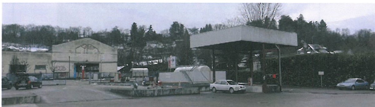
Fig.3. Site vu à partir de l'aval. Les anciens quais de chargement sont abrités par un auvent.
