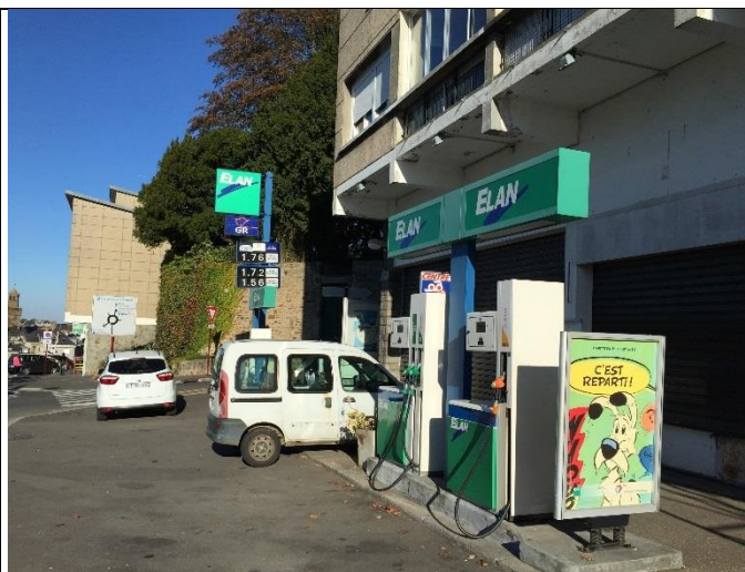
Photographie 4 – Pompes à carburants
