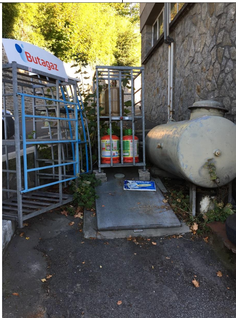
Photographie 5 – Citerne, cuve enterrée, bouteilles de gaz
